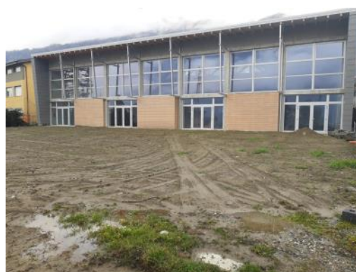
Prospetto sud della nuova palestra
